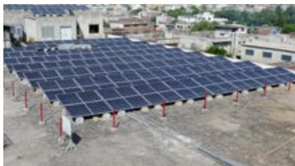
Nouveaux efforts en matière de développement durable à l'usine de fabrication de ballons. L'installation de **404 modules de panneaux solaires** sur le toit de l'usine de ballons. L'installation devrait permettre de **réduire les émissions de CO<sub>2</sub> de 270 tonnes par an**. L'usine est également certifiée ISO 14001 pour l'environnement et SMETA 4 piliers.
